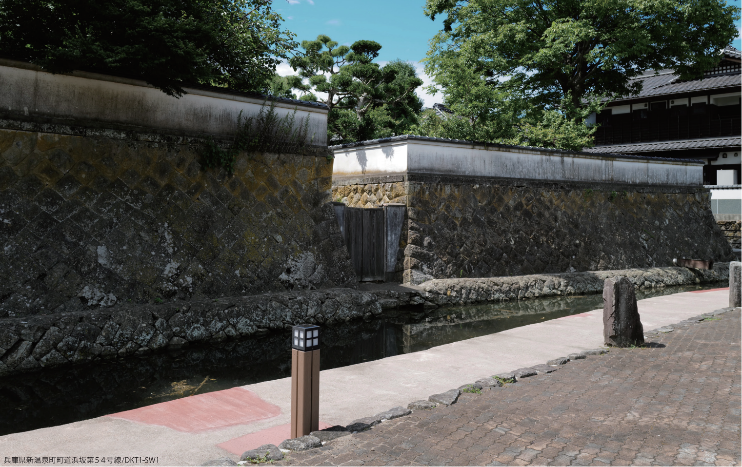
兵庫県新温泉町町道浜坂第54号線/DKT1-SW1
