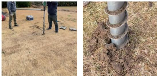
1. 施工予定位置に螺杭打ち込み 2. 螺杭打ち込み状況
