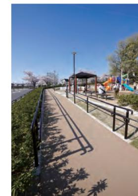
脱色アスファルトスロープ地覆り コア抜き基礎 アルミセンター2段
