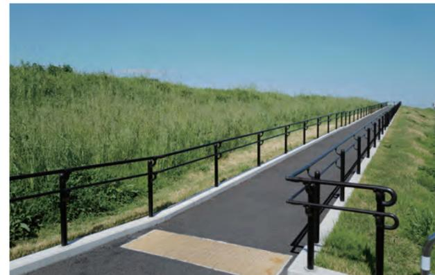
アスファルトスロープ地覆り コア抜き基礎 アルミフロント2段 J端末
