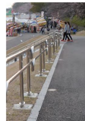
アスファルトスロープ独立基礎 脱着式 SUSセンター2段
