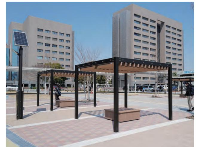
防災タイプ 大学病院前 縁台に収納されているテントを桁のアイボルトから吊って設置します。
