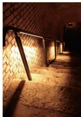
石材階段 コア抜き基礎 アルミセンター1段 ライン照明
