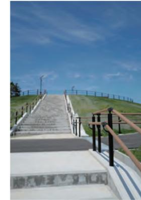
地覆りコンクリート階段 コア抜き基礎 SWセンター2段
